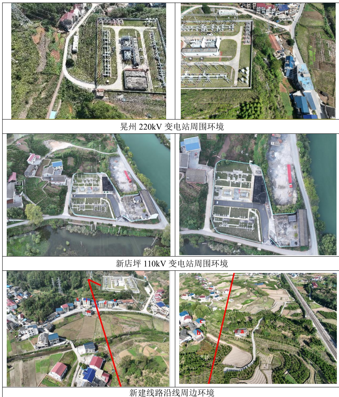
图 9 本工程环境现状
